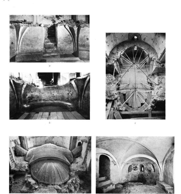
$a\ b$ Befund nach der Ausräumung der Einbauten – c Drahtmodell für die Einwölbung – d Lehrgerüst e die wiederhergestellte Krypta
