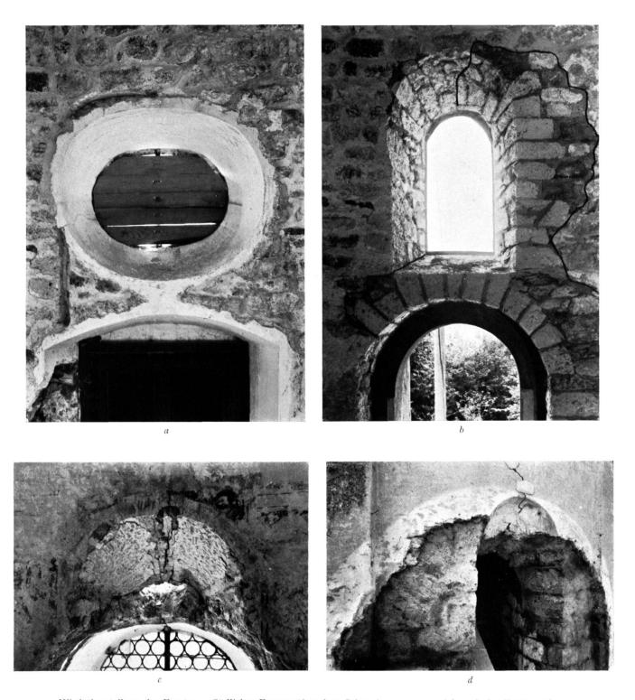
Wiederherstellung der Fenster. a Südliches Fenster über dem Seiteneingang vor und b nach der Restauration c d Mittleres Fenster der Hauptapsis – c Innenansicht (Befund) – d Außenansicht des ergänzten Fensters
