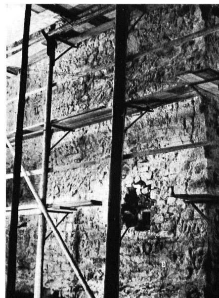
d. Südquerschiff.Westwand mit Reklusenfenster
