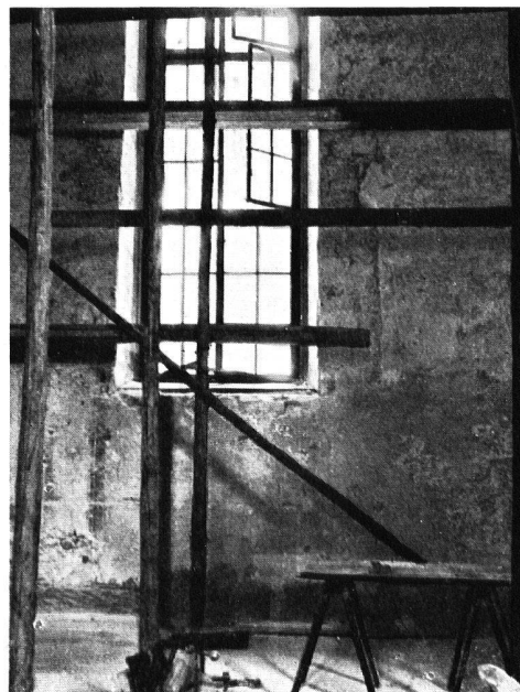
b. Nordquerschiff, Giebelwand. Romanisches Fenster rechts am Fuß des heutigen Fensters (vermauert)
