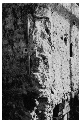
f. Innenecke D. Urspr. Verstärkung mit Tuffquadern. Rechts das sog. Wiborada-Fensterchen
