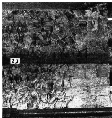
f. Verstärkung der Ecke H mit Sand- steinquadern (oberes Stück). Nordwand
