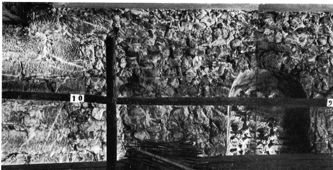
a. Südquerschiff. Romanisches Fenster in der Ostwand (vermauert); links (nicht mehr ganz sichtbar) Ecke E.
