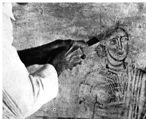
Abb. 4. Kirche von Zillis. Die Abdeckungsarbeit wird unrichtiger Weise mit einem ungeeigneten, zu breiten Instrument durchgeführt
