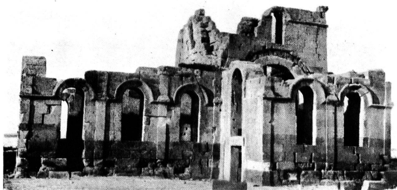
a. Tomarza, Panagia, Ansicht von Südwesten (n. Rott)
