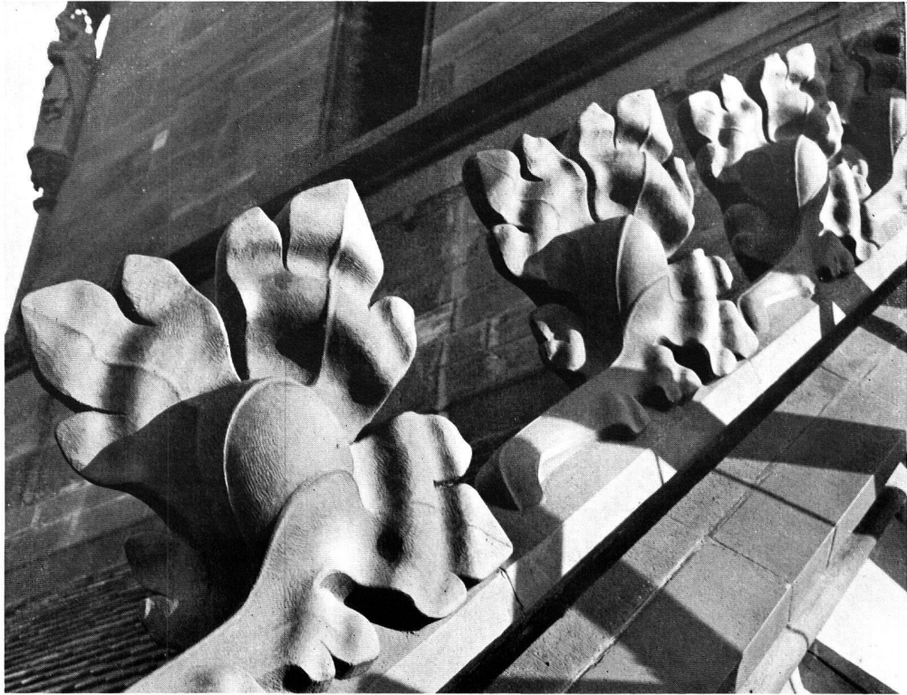
Abb. 1. KRABBen AM GIEBEL DER SCHALERKAPELLE, Neuanfertigung
