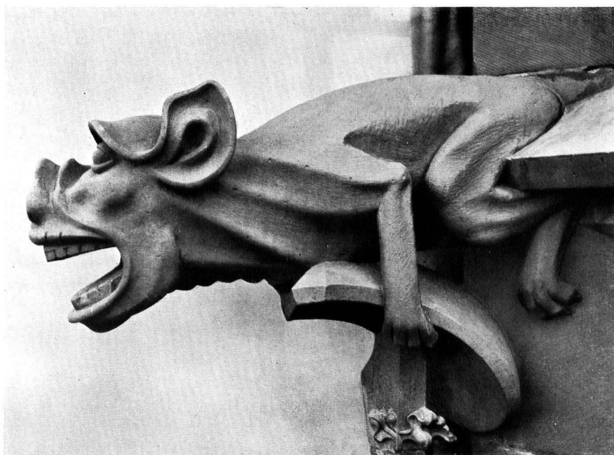
Abb. 2. Neuanfertigung WASSERSPEIER AM MARTINSTURM.
