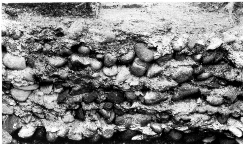
1. DIE MAUERTECHNIK DER ARSENALFUNDAMENTE
