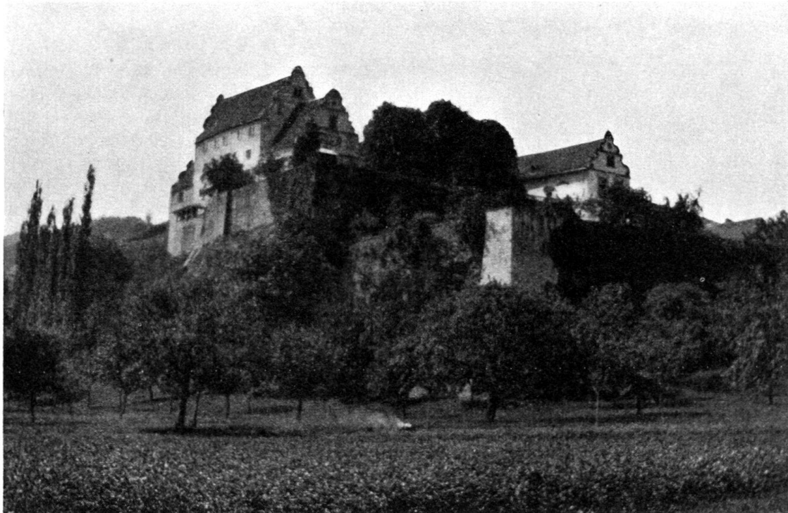
Fig. 1. Le château de Castelen, peu avant l'incendie
