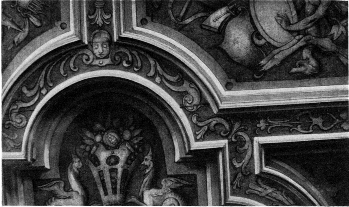
Fig. 2. Détail d'un plafond à caissons du château de Castelen. XVII e siècle
