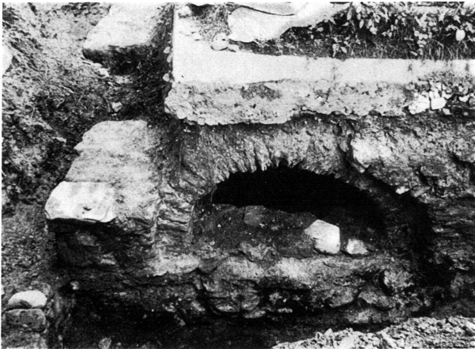
Abb. 9. Die Fensterfassung des Seitenstollens. Außenansicht.
