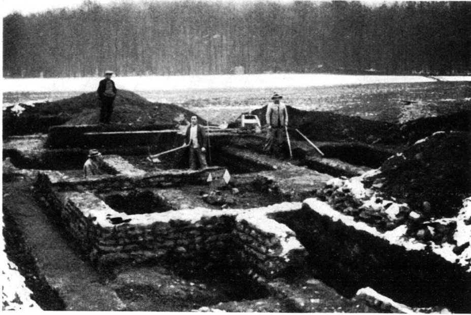
Abb. 2. Haus 1, Räume 5—9 von Süden (Grabung 1933).
