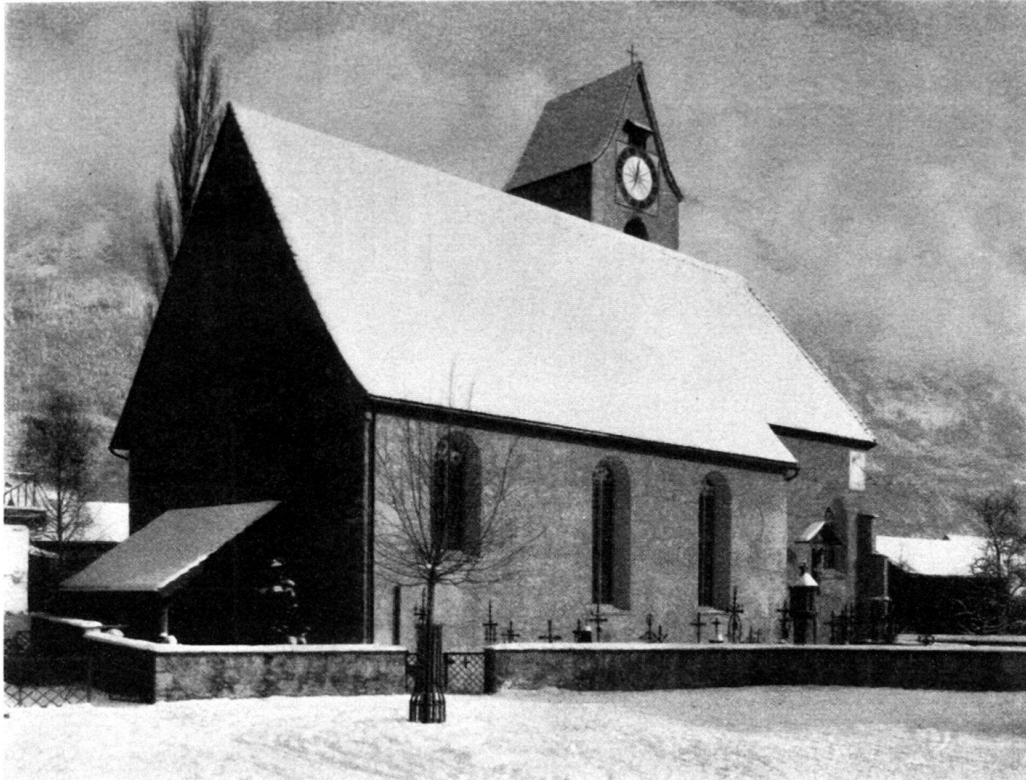
Abb. 1. Kirche St. Justus in Flums. Photo Schweiz. Landesmuseum Das Äußere nach der Renovation von 1932/33. (Vgl. Abb. 1 a. S. 237 im Jahrgang 1934.)
