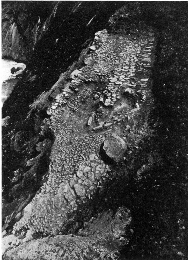
Abb. 2. Zufahrtsweg zur alten Teufelsbrücke von Andermatt her.
