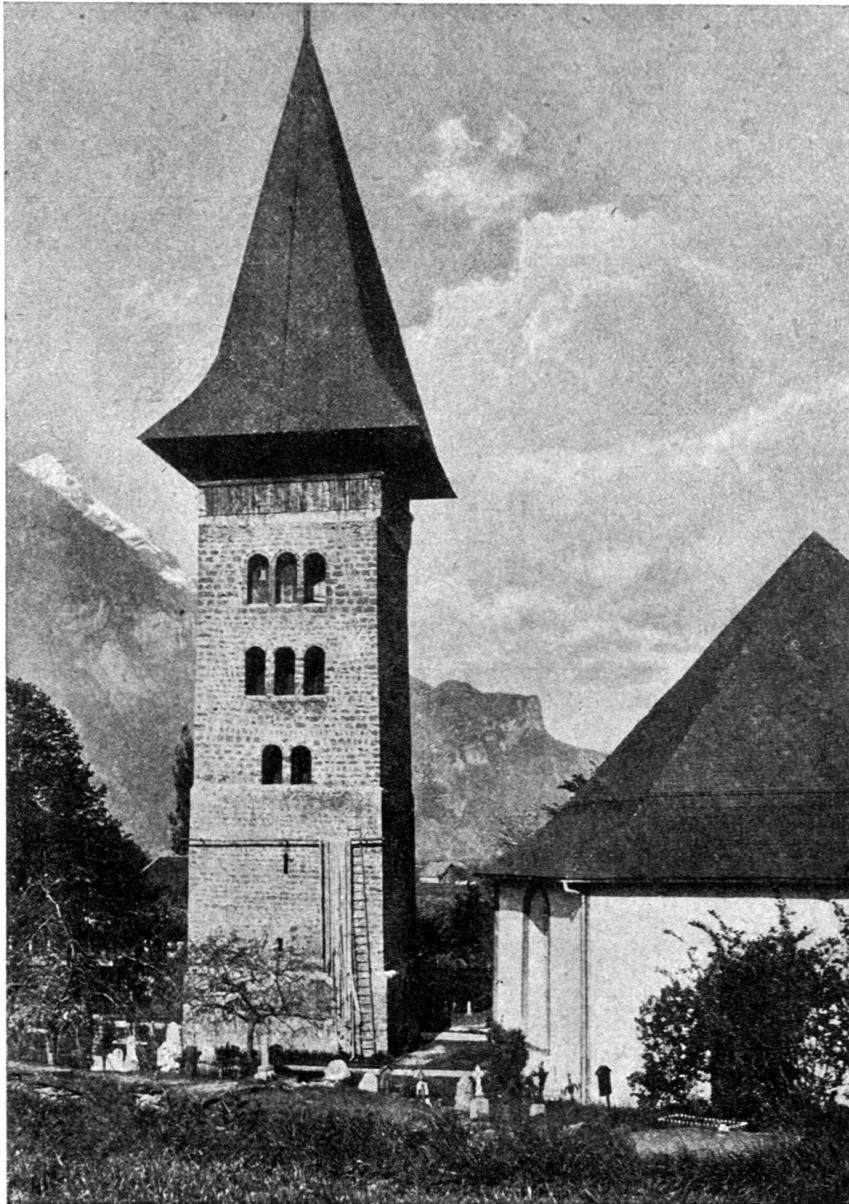
Fig. 1. Der romanische Glockenturm neben der Meiringer Kirche in seiner heutigen Gestalt. Ansicht von der Ostseite. Rechts daneben der Chor der Kirche. (Zur Zeit der photographischen Aufnahme waren gerade an der untern Turmhälfte eine Leiter angestellt und Wasserschläuche zum Trocknen aufgehängt). Hinten die Alpen in Richtung Rosenlauri.
