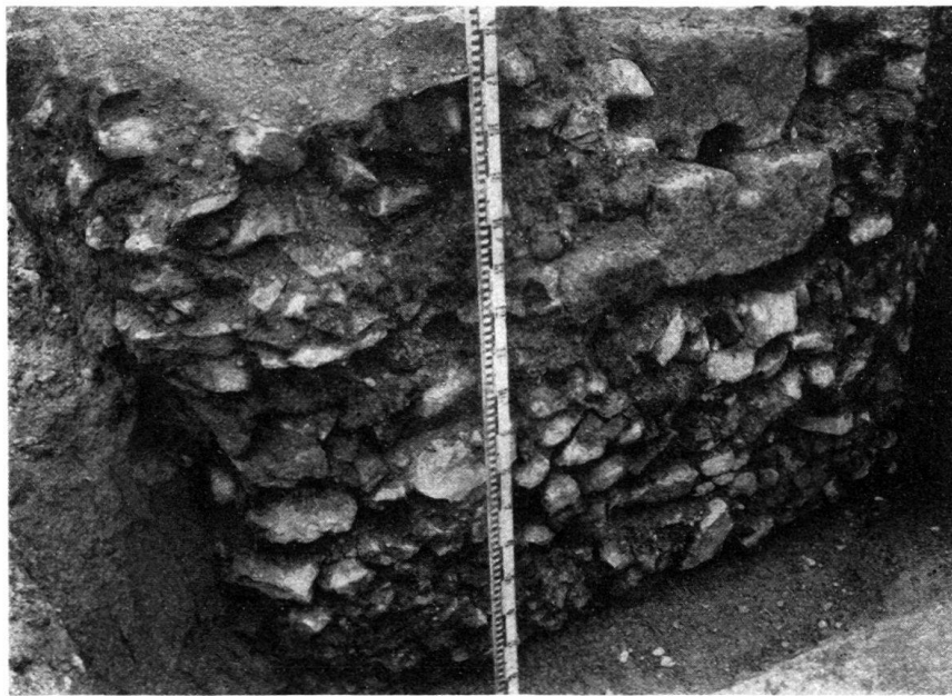
Abb. 4. Fundamentklotz im Kanal der Via principalis [F. 3].
