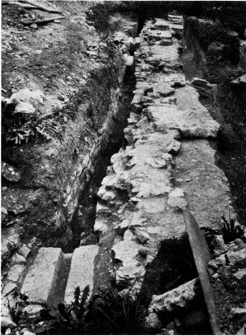
Abb. 4. Straßenkanal mit Rinnsteinen (von N nach S).
