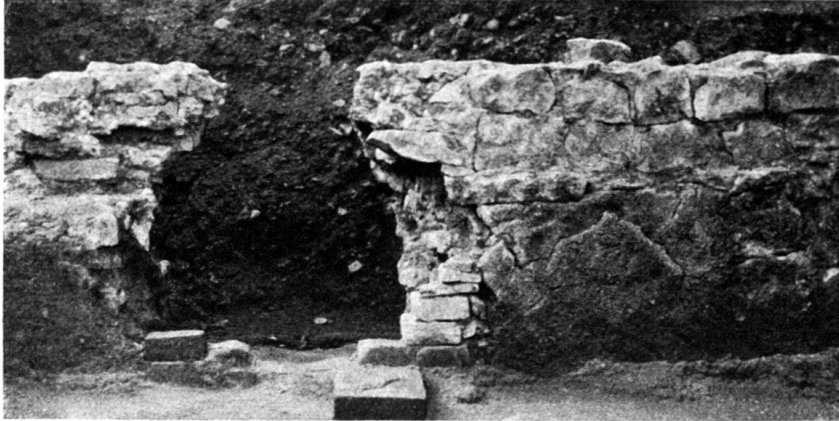
Abb. 9. Mauertechnik der II. Periode.
