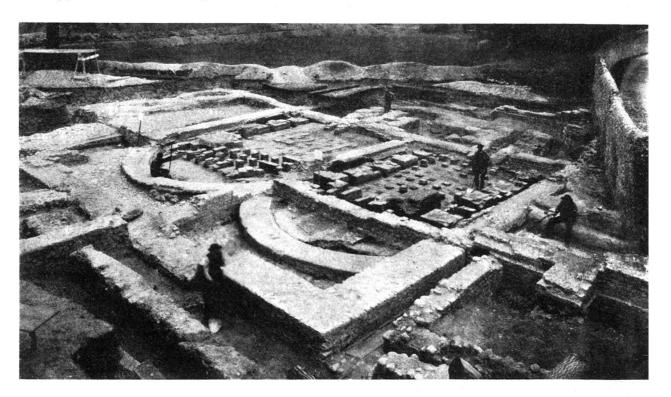
Fig. 8. Les hypocaustes de l'établissement de bains. Fouilles 1906.
