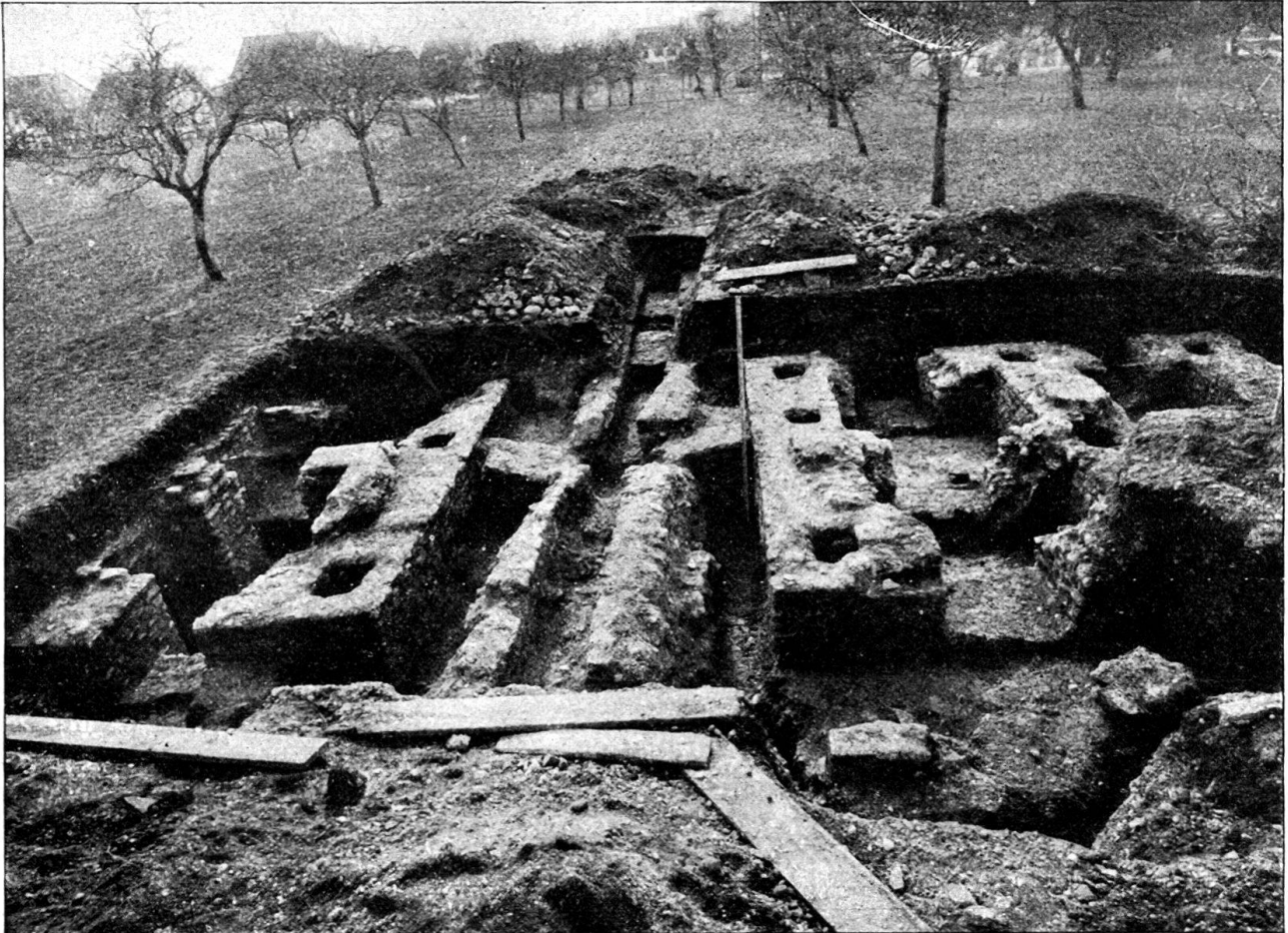
Abb. 7. Vindonissa Südtor. Aufnahme von Norden (Lagerseite) 1. III. 1922. (Der störende Erdklotz außen rechts (Mitte) konnte wegen eines darin stehenden Baumes nicht abgehoben werden.)
