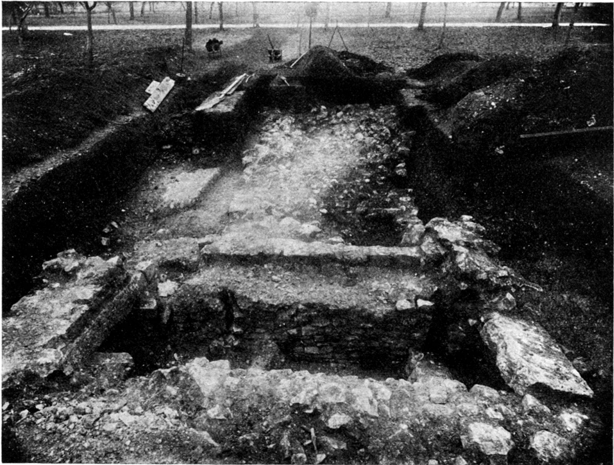
Abb. 4. Wehrturmfundament (mit Wasserdurchlaß) und östlich anstoßendem Wallfundament. Aufnahme von Westen 15. XII. 1921.
