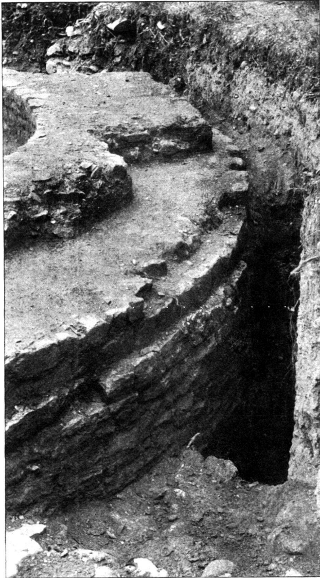
Abb. 2. Fundament des Torturmes T 1 . Photographische Aufnahme von K. Stalder, 20. Oktober 1919.
