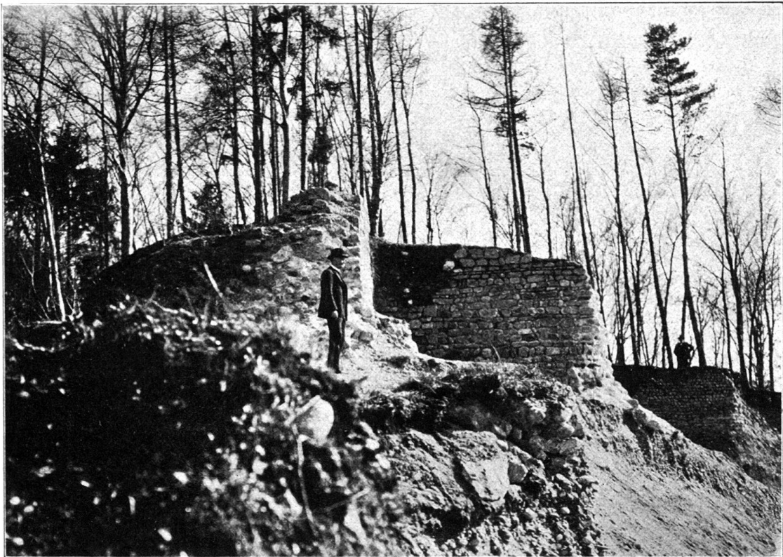
Abb. 3. Ansicht der Ruine von Norden.
