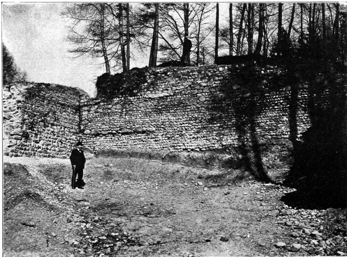
Abb. 4. Ansicht von Süden aus dem Zwinger gegen den Wohnturm.
