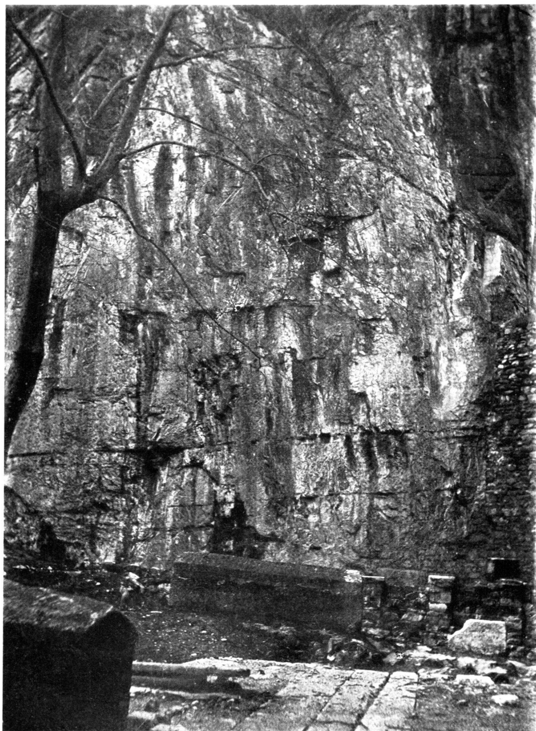
Emplacement des basiliques du IV e et du VI e siècle, adossées au rocher. Rainures du toit et entailles des poutres équarries, des entrails de la charpente apparente.
