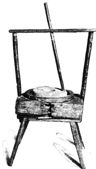
Abb. 28. Handmühle einfacher Gestalt ohne Eisenteile. Die Lenkstange steckt in einem Loch des Läufers, nicht seitlich in einer Öse. Slav.-ethnogr. Mus. in Prag. Orig.
