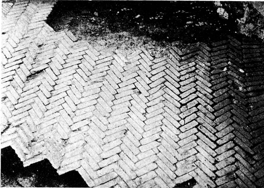
Abb. 3. Mötteliboden im Bau von Unterwindisch. (Aufnahme von Edm. Fröhlich).
