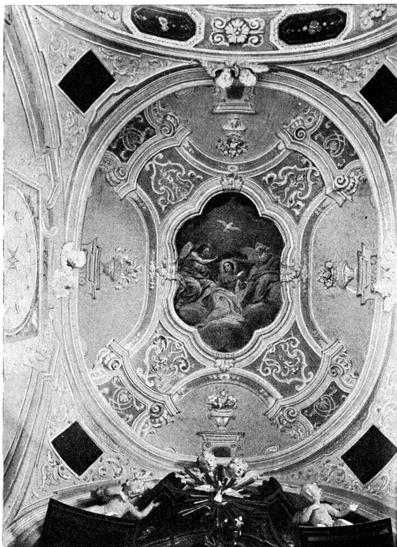
Stucchi della volta della capella della Madonna nella chiesa di St. Abbondio in Gentilino e Montagnola, eseguiti nel 1730 da Carlo del Fè di Viglio.
