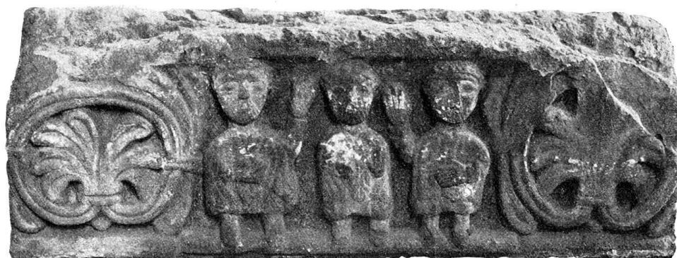
Abb. 3. Kranzgesims von der romanischen Portalumrahmung.
