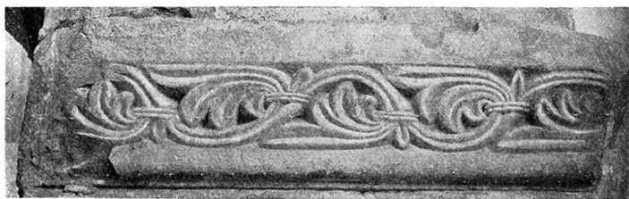
Abb. 5. Gesims an der Nordseite des ersten nordöstlichen Pfeilers.
