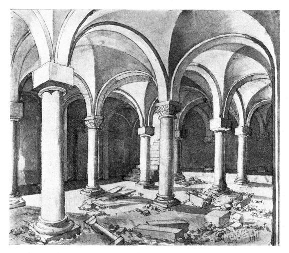
Abb. 14. Rekonstruierte neue Krypta vor der Ausführung der Kapitellskulpturen. (Vgl. Grundriss, Abb. 2.) Zeichnung von J. R. Rahn, 7./8. Sept. 1911.
