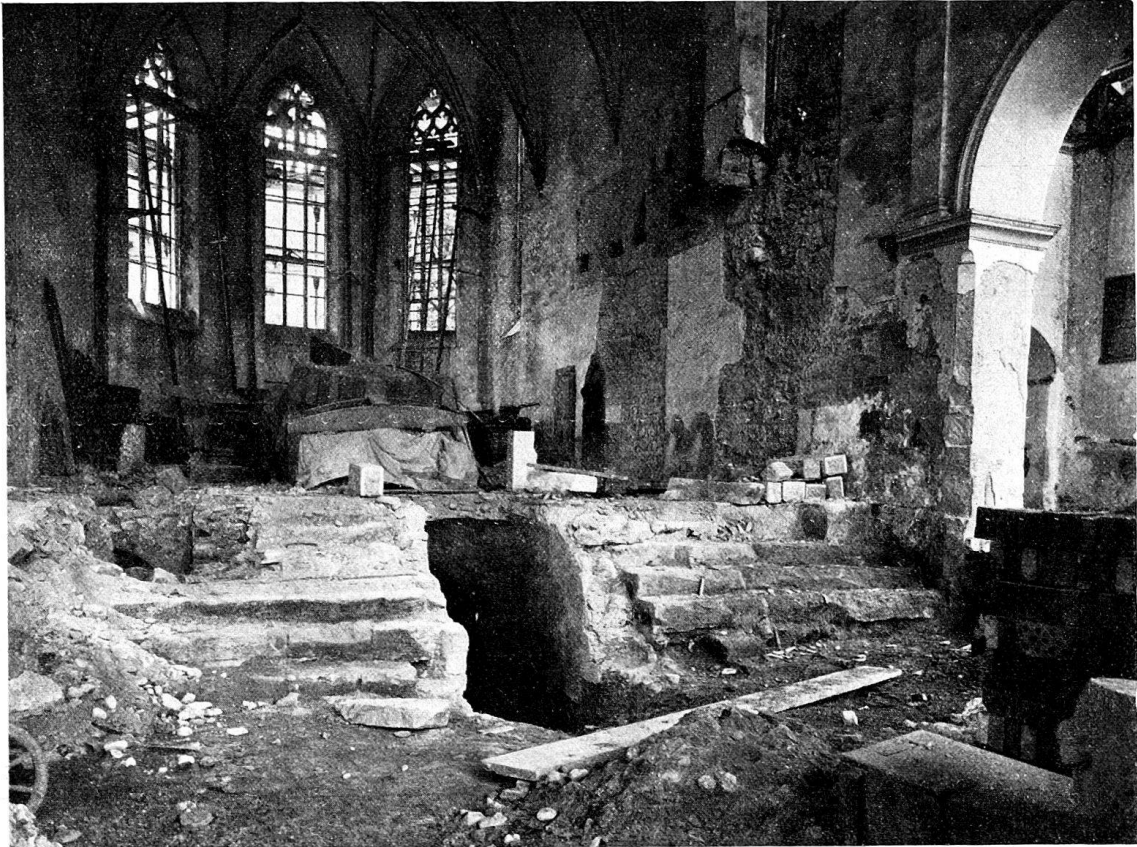
Abb. 10. Ansicht des Chores, mit dem 1910 aufgedeckten Abstieg zur kleinen Krypta.
