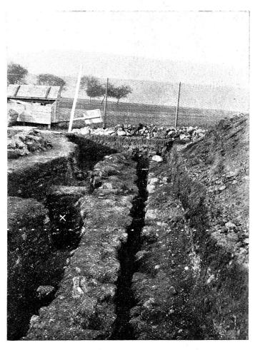
10. Kanal neben der Via principalis. × westlicher Seitenkanal (vgl. S. 42, g-h und S. 43). letztere Kanal ist an den Seitenwänden noch mit fast unversehrtem Ziegel-
