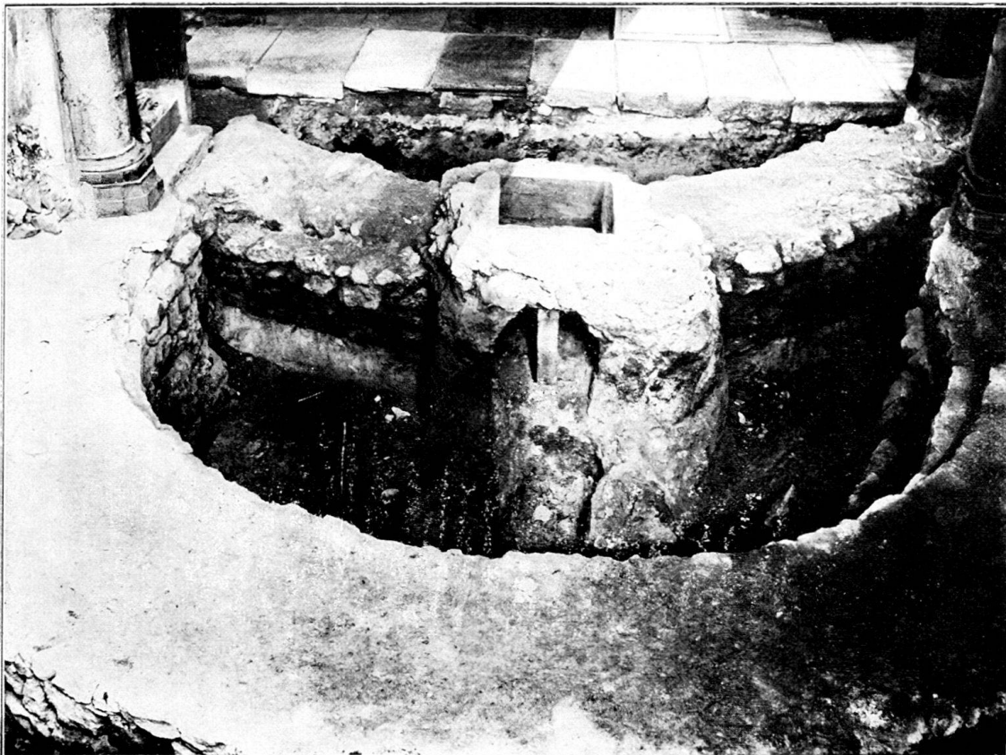
Vue prise de l'Est vers l'Ouest; premier plan, fondations de l'abside du X e S. qui coupent un tombeau sur la droite; au 2 e plan, abside du VIII e S., coupée au centre par le tombeau du prieur Jean de Seyssel.
