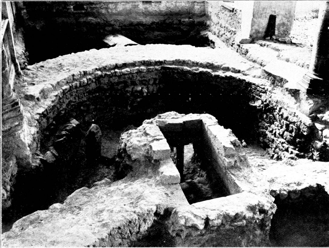
Vue prise de l'Ouest vers l'Est. Au premier plan, tombeau du prieur Jean de Seyssel, coupant l'abside du VIII e S.; second plan: abside du X e S., avec retranche au niveau du sol primitif, et dont les fondations coupent, sur la gauche, une sépulture; au fond, l'ambon couché, tel qu'il fut trouvé.
