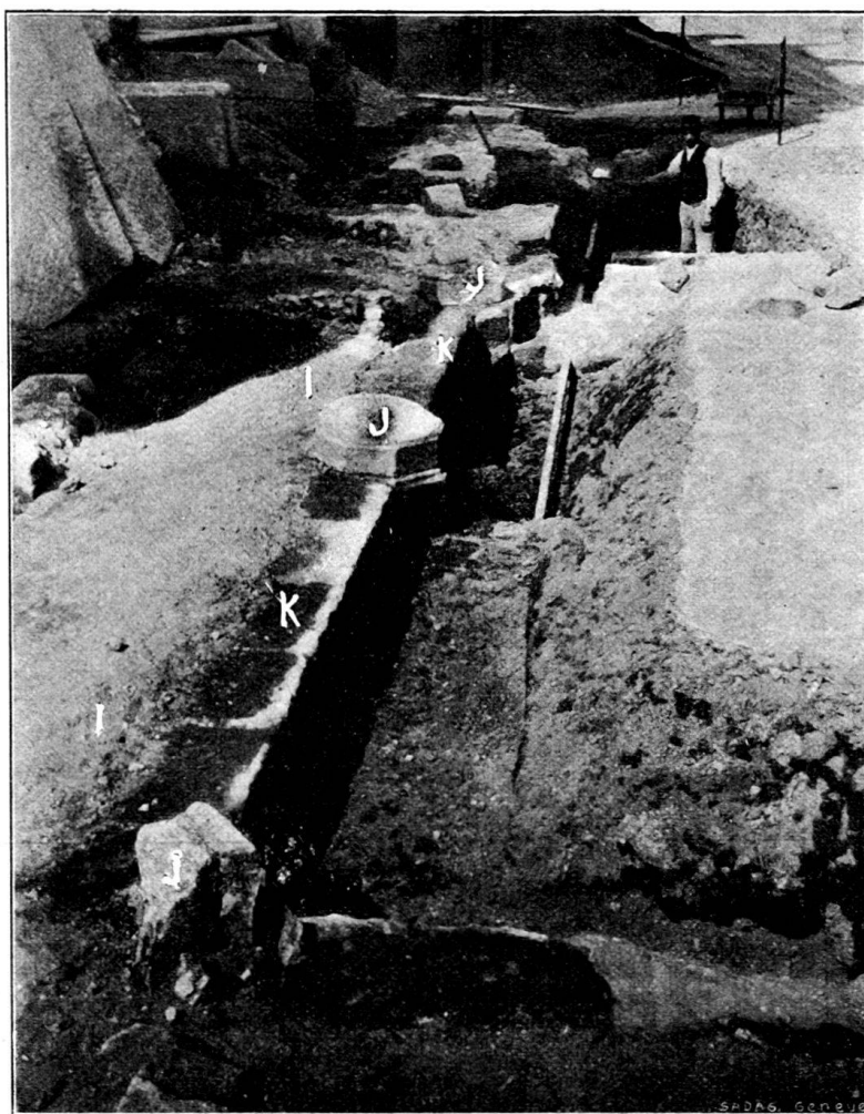
Fig. 64. I Mur méridional du bâtiment capitulaire. — J Bases de colonnes. — K Le banc continu de la salle du chapitre. — + Au nord du chœur de la cathédrale se trouvait une porte donnant accès „aux cloîtres“ (Plantin).
