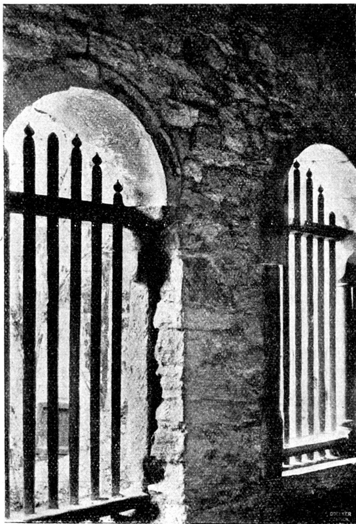
Fig. 95. Ursprüngliche Fenstersäule im Ostflügel.
