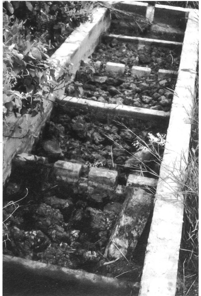
In den Filtern finden lokale Materialien wie z.B. Vulkanschlacke Verwendung. In drei bis sechs Tagen durchläuft das Abwasser die Kammer.
