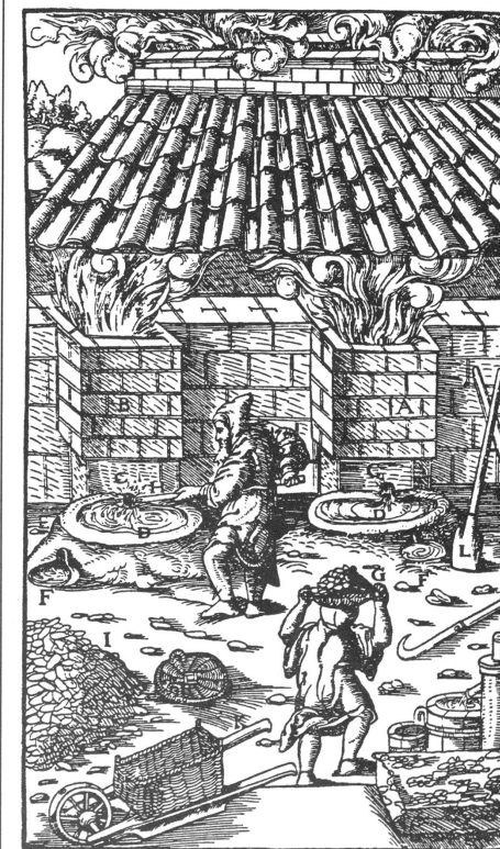
Schachtfen wie sie im Mittelalter zum Rosten der schwefelhaltigen Kupfererze verwendet wurden, nach Georg Agricola 1556
