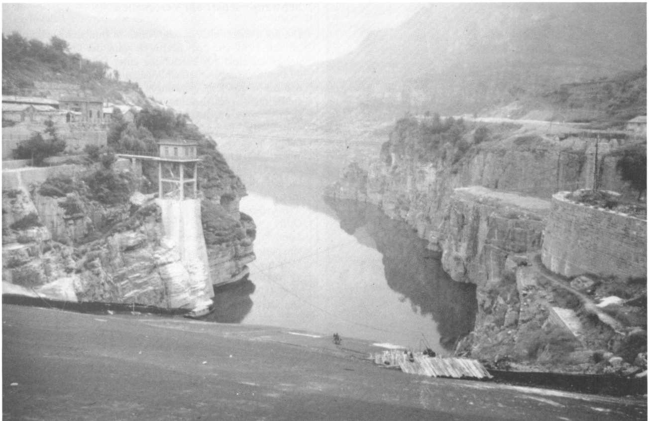
Talsperre Nangudong, Lin Xian in Henan, mit 75 Mio m 3 Inhalt, 1958 erbaut und 1975 durch Überspülen schwer beschädigt
