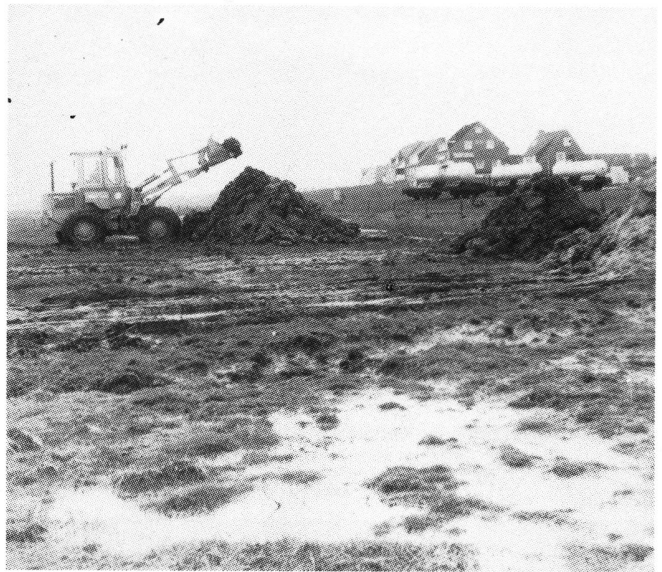
Der durch behördlichen KFZ-Verkehr ruinierte Deichfuß wird repariert. Große Hellerflächen gehen dabei zugrunde.
