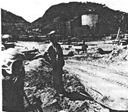
KWU-Baustelle in Brasilien
