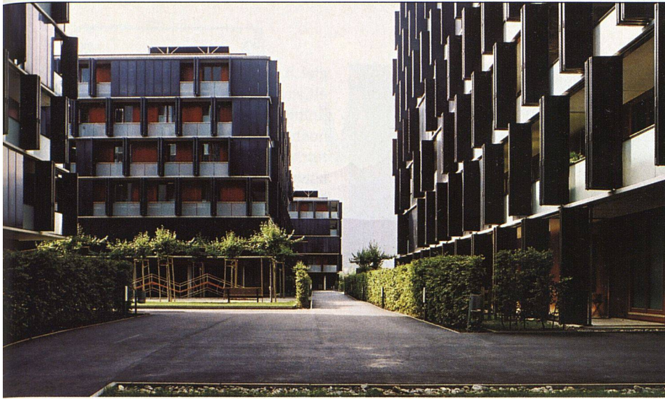
Bei der Siedlung am Lohbach in Innsbruck setzten die Architekten Baumschlager und Eberle auf Trockenbau.
