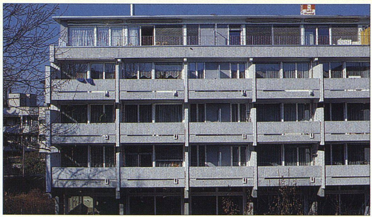
Das neue Antlitz nach der Sanierung wirkt wesentlich freundlicher.
