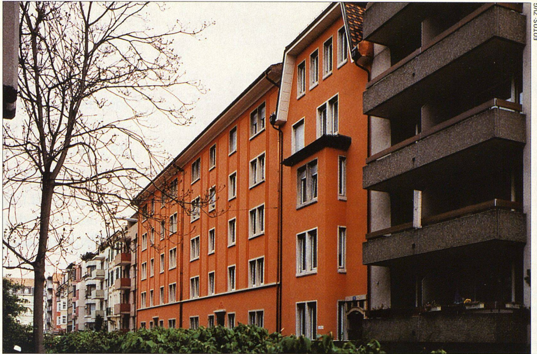
Die Liegenschaften der BWG an der Gundeldingerstrasse 419 und 423 bringen Farbe ins Strassenbild.
