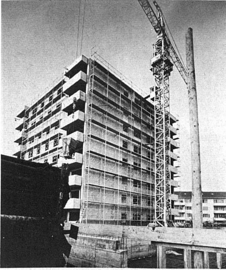
Rohbau 32-Familien-Haus, Baujahr 1971
