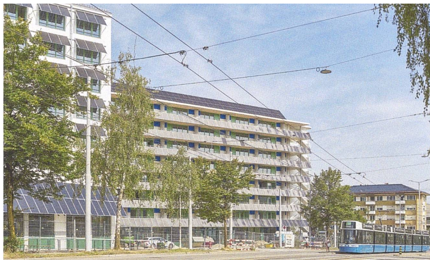
Blick von der Strasse auf die beiden Gebäude der Wohnsiedlung. Ihre auffälligen Fassaden mit schräg angehängten PV-Standardmodulen, die gleichzeitig als Sonnenschutzschilder dienen, gaben Anlass zu kontroversen Diskussionen.
