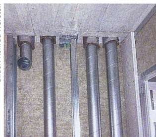
Bei ihrer Siedlung Eidgenossenweg hat die Baugenossenschaft des Bundespersonals Basel eine Schwerkraftlüftung eingebaut. Sie funktioniert ohne Ventilator und besteht aus einem Einlass in Fusshöhe (Bild zuunterst), einer Abluftöffnung unter der Decke und Rohren für die Luftabfuhr.
