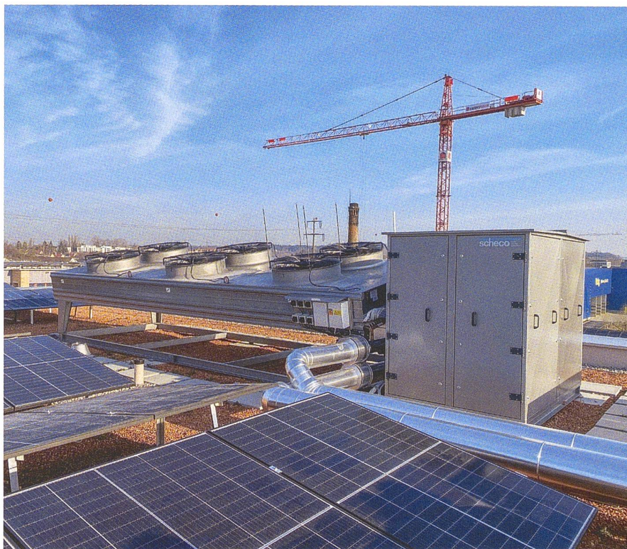
Die Luft-Wasser-Wärmepumpe des Pilotprojekts auf dem Hobelwerk-Areal wird bei Spitzenlasten von einer Holzpelletfeuerung unterstützt. Durch den Einsatz von KI soll die Bivalenzregelung so optimiert werden, dass die Feuerung möglichst selten zugeschaltet wird.
