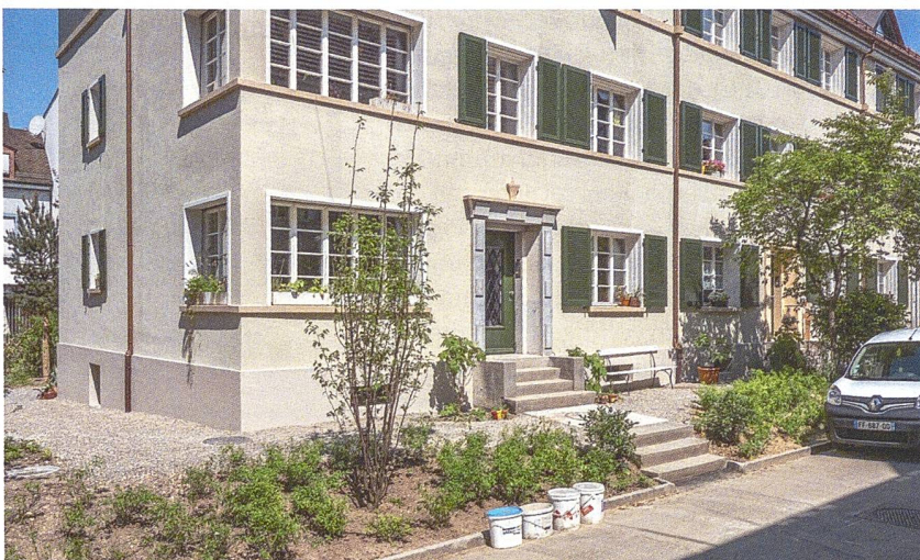
Die Fassade wurde mit Aerogel-Dämmputz saniert. Das trug zur Akzeptanz der Denkmalpflege bei, verursachte aber zusätzliche Kosten. Der Aussenraum wurde weitgehend in den Originalzustand zurückgeführt, bietet den Mietenden neu aber einen Pflanzbereich.
