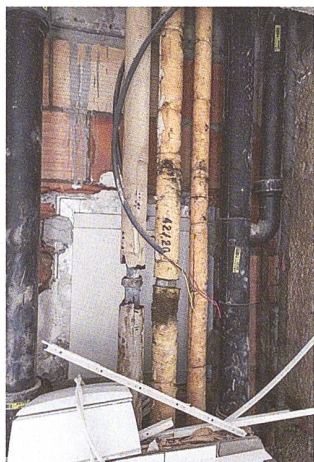
Nach fünfzig Jahren mussten alle Leitungen ersetzt werden. Die Sanierung erfolgte in bewohntem Zustand, den Mietparteien standen Kochplatten und zentrale Zapfstellen für Kaltwasser sowie Ausweichangebote zur Verfügung.
