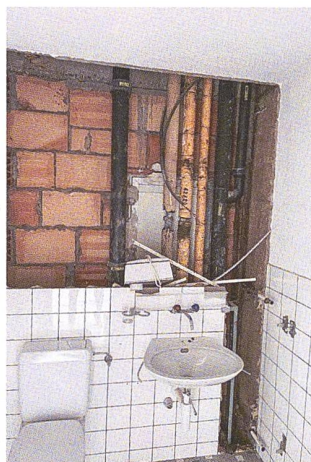
Nach fünfzig Jahren mussten alle Leitungen ersetzt werden. Die Sanierung erfolgte in bewohntem Zustand, den Mietparteien standen Kochplatten und zentrale Zapfstellen für Kaltwasser sowie Ausweichangebote zur Verfügung.
