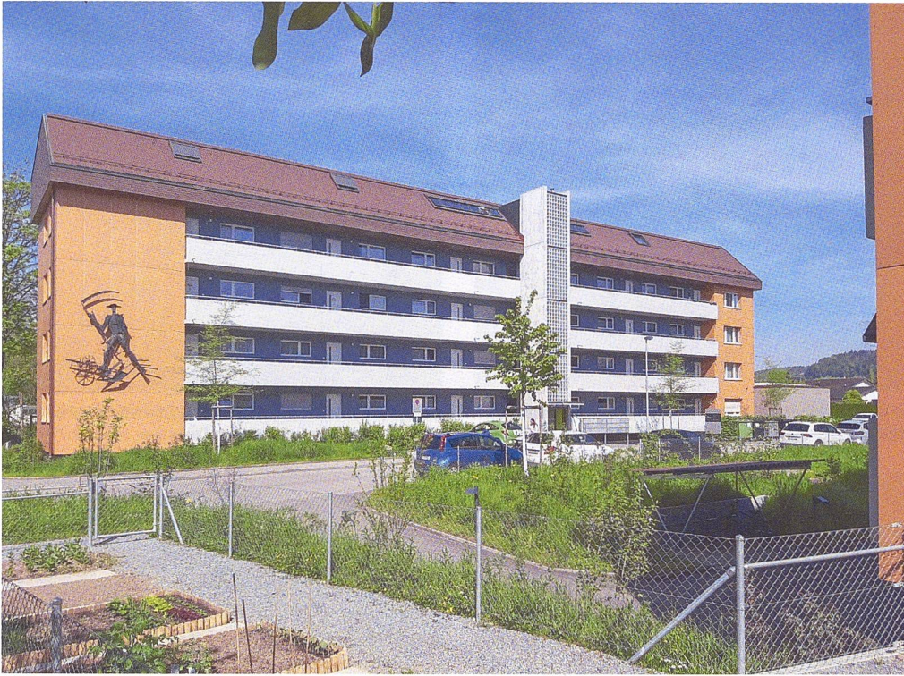
Sichtbare Zeitschichten: Bereits 1985 gab es eine Sanierung. Dabei wurden hinterlüftete Fassaden angebracht, deren Platten Asbest enthielten. Ihr Ersatz wäre zu teuer geworden, sie wurden deshalb nur gereinigt. Neu haben nun alle drei Gebäude Betonanbauten für Lifte erhalten.
