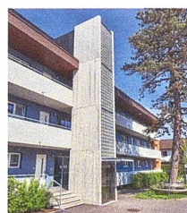
Siedlung Giessächer in Fahrweid (ZH) der Siedlungsgenossenschaft Eigengrund. Durch Liftanbauten sind die 1960er-Jahre-Gebäude besser zugänglich, dank Ausbau der Dachgeschosse entstand neuer Wohnraum.
