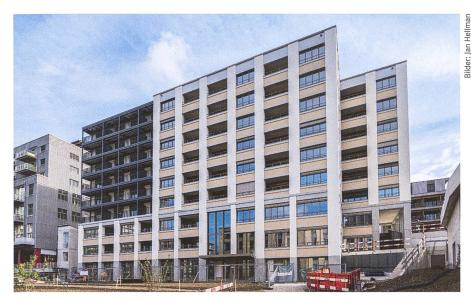
Beim Fambau-Gebäude wurden Teile der ehemaligen KVA-Garagen als Hangsicherung stehen gelassen und in den Bau integriert. Sie werden nun als Einstellhalle genutzt.
