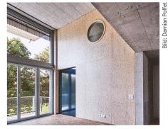
den wurden vor allem robuste und möglichst wenig behandelte Materialien verwendet: Sichtbeton, Metalltreppen mit Holzstufen, Einbauschränke aus Sperrholz, Eichenparkett und Gussasphalt prägen das Bild. Schnetzler: «Wir wollten Ehrlichkeit. Das sind echte Materialien, das darf man auch sehen.» Wo immer möglich, wählte die Genossenschaft Baustoffe und Lieferanten aus der Umgebung aus. Bei den Waschmaschinen und Tumblern entschied sie sich für ein kreislauffähiges Mietmodell.
