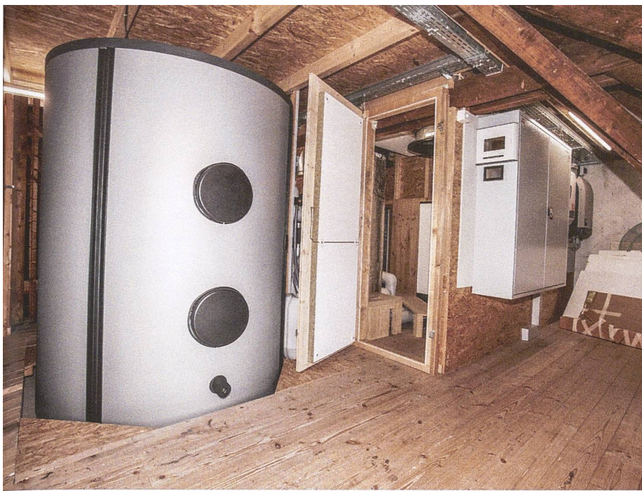
Die Luft-Wasser-Wärmepumpen wurden in einem schallisolierten Technikraum im Dach untergebracht. Davor wurde ein 2000 Liter fassender Wärmespeicher installiert.
