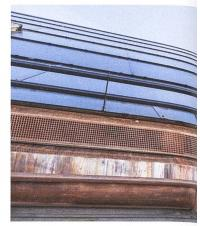
Eine Besonderheit des Anlagenkonzepts ist die Hinterlüftung der PV-Dachflächen. Auf den Bildern sind das Luftausblas- und das Luftansauggitter über der Regenrinne im Solardach zu sehen.
