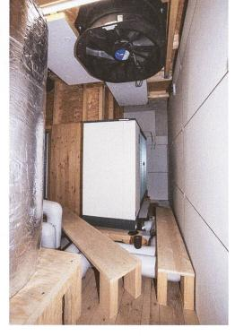
Die Luft-Wasser-Wärmepumpen wurden in einem schallisolierten Technikraum im Dach untergebracht. Davor wurde ein 2000 Liter fassender Wärmespeicher installiert.
