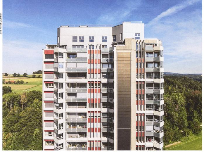
Die Fambau-Genossenschaft brachte an den Süd- und Westfassaden der Holenacker-Hochhäuser in Bern goldbraun schimmernde Photovoltaikmodule an. Experten der Gebäudeversicherung Bern entwickelten dafür eine Musterlösung für möglichst brandsichere PV-Hochhausfassaden.
