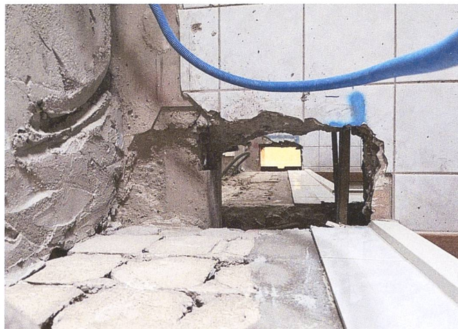
Wegen kantonalen Auflagen mussten sämtliche Wasserleitungen, Abflussrohre und Kanalisationsanschlüsse erneuert werden, zudem mussten alle Deckendurchbrüche mit Brandschutzmanschetten verschlossen werden.
