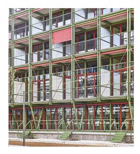
Mit der vertikalen Blechfassade, dem maschinengrünen Anstrich und der Stahlkonstruktion, die die Balkone trägt, verweisen die Architekten auf die industrielle Vergangenheit des Weinlagers.
