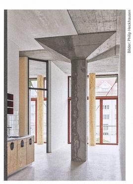
Im ganzen Haus trifft alter auf neuen Beton. Die Hauptrolle spielen im Innern aber die markanten Pilzstützen aus der ursprünglichen Bausubstanz. Sie erzählen auf eindrückliche Weise die Geschichte des Hauses.
